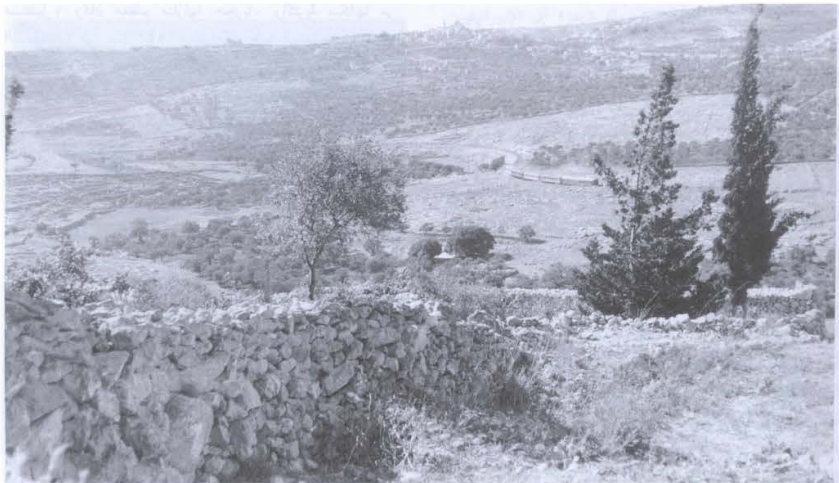
قرية المالحة كما تبدو للمناظر إليها من مسافة ما وراء خط سكة الحديد (تموز/يوليو - آب/أغسطس ١٩٤٤) [المالحة]
